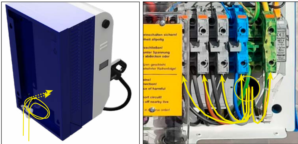
Abb. 14: Kabeleinführung Aufputz
